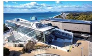
高知県立坂本龍馬記念館 外観(上空より):本館(左)、新館(右)
