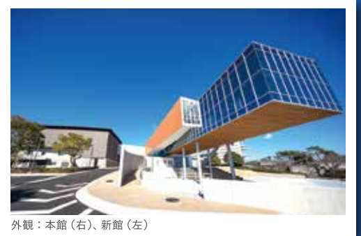
外観：本館（右）、新館（左）
