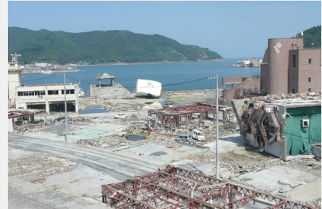
津波が到達した25メートルの高台の駐車場から女川港を見下ろす。津波はこの高さまで到達し、車を破壊した。
